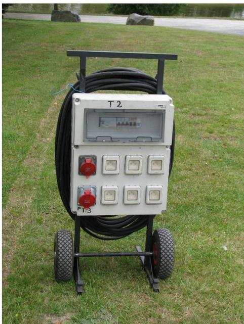
Tableau électrique triphasé 380 volts, 50m de câbles, ses deux prises
